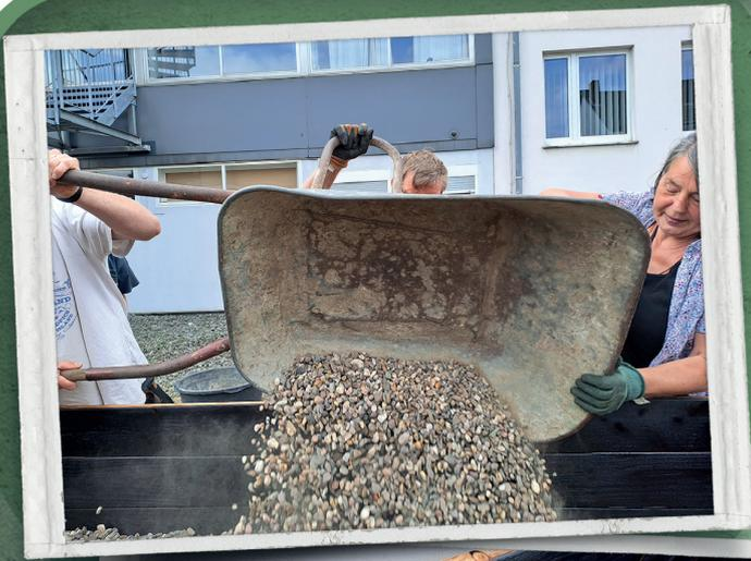
Die unterste Lage der Befüllung besteht aus einer ca. 5 cm dicken Drainage aus Kies zum Schutz vor Staunässe.
