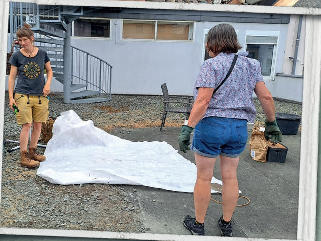
Ein wasserdurchlässiges Vlies hält die Erde über der Drainageschicht. So mischt sie sich nicht mit dem Kies.
